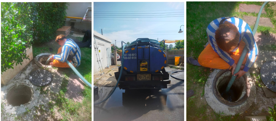
ภาพที่ 4-39 ดูดตะกอนบ่อเกรอะของระบบบำบัดน้ำเสีย
