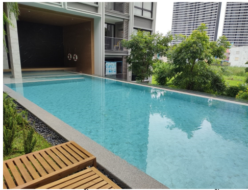
ภาพที่ 4-23 โครงสร้างสระว่ายน้ำ คอนกรีตเสริมเหล็ก ปูกระเบื้อง ไม่มีรอยแตกร้าว
