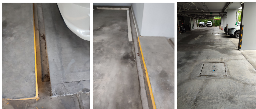
ภาพที่ 4-22 แนวรางระบายน้ำและท่อระบายน้ำและฝาท่อเป็นฝาคอนกรีต ไม่มีขยะอุดตัน
